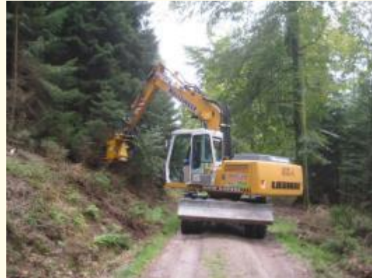
Herstellung Lichtraumprofil
